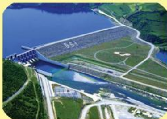
BARAJ KAPAĞI HİDROLİK TESİSATI
