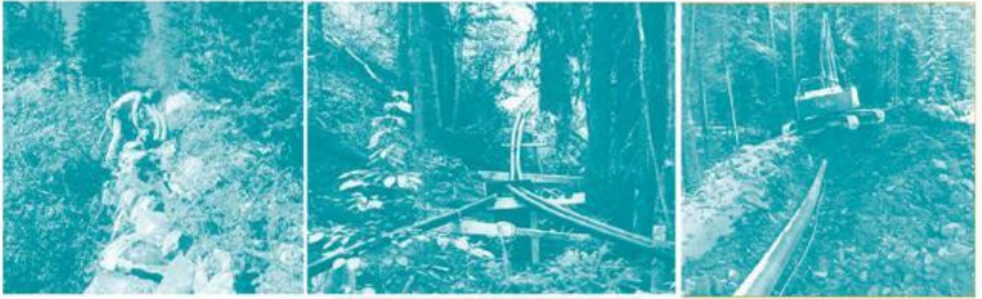
Şekil 8. 2 Cebri Borunun Yerleştirilmesi
