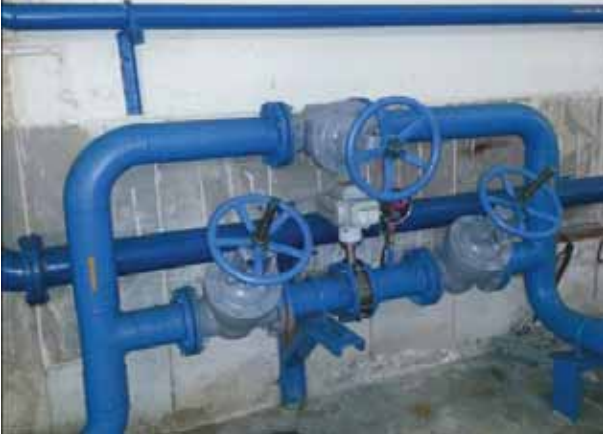
Resim-3 Açık Devre Soğutma Sisteminin Vana Kısmı
