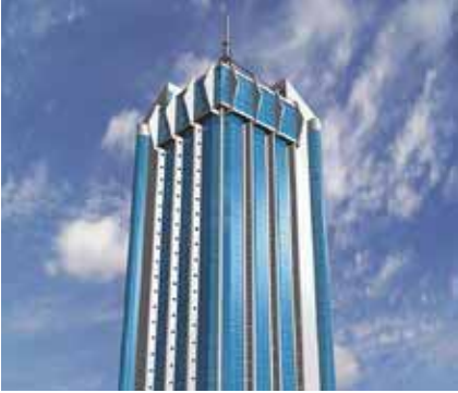
Sudan Telekom Binası / Cephe Film PV uygulaması
