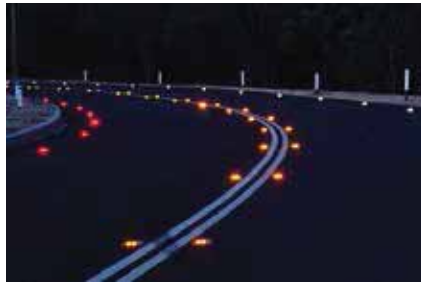
Yollardaki solar butonlar Kaynak: www.futurelightco.za
