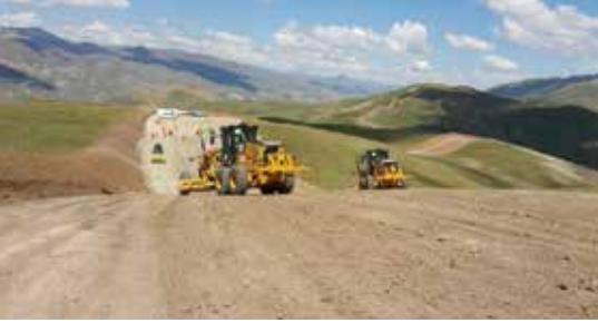
Boru hattının yapılacağı güzergâhta iş makineleri tarafından yapılan sıyırma ve tesviye kazısından bir görünüş.
