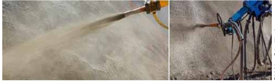
Püskürtme Beton Uygulaması
